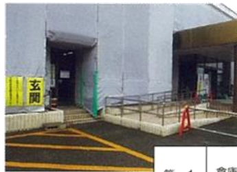
改修工事中の入口はこちら
